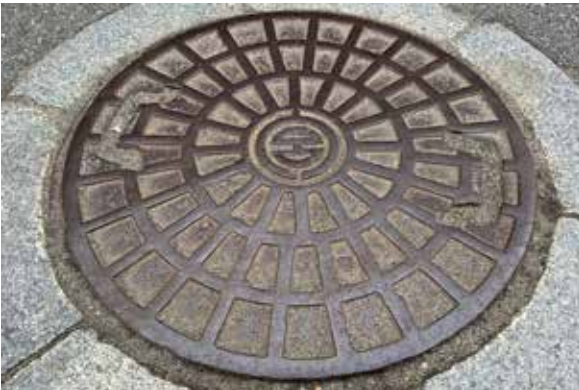
▼宮内庁の「宮」マークが入ったマンホールはレアもの。
