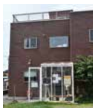
レンガ造りのような外観が目印。1個約13kgのブロックを積み上げた建物は、設計士によると300年はもつという
