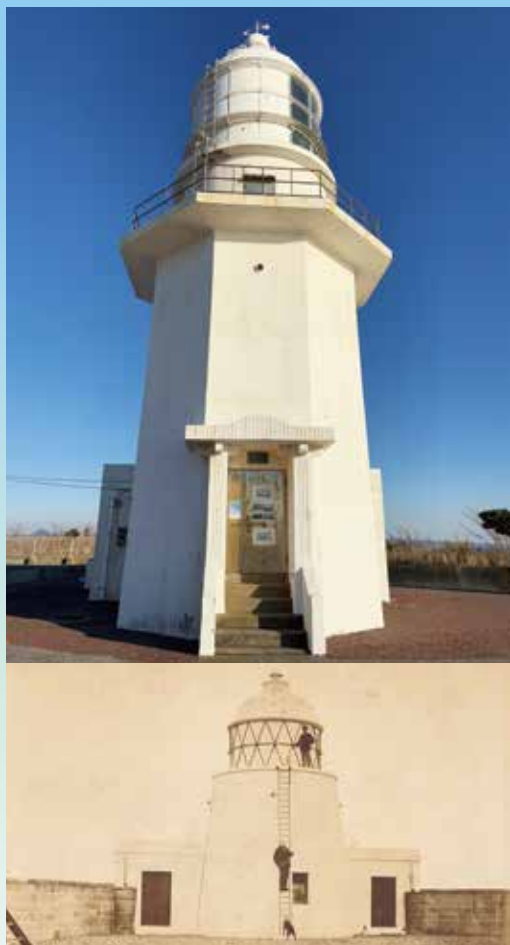
上) 車で行くには道が狭いので、アクセスはサイクリングがおすすめ。下) イギリス人技師リチャード・プラントンが手がけた石造りのどっしりとした旧灯台。関東大震災で被災し、現在の灯台が造られた
